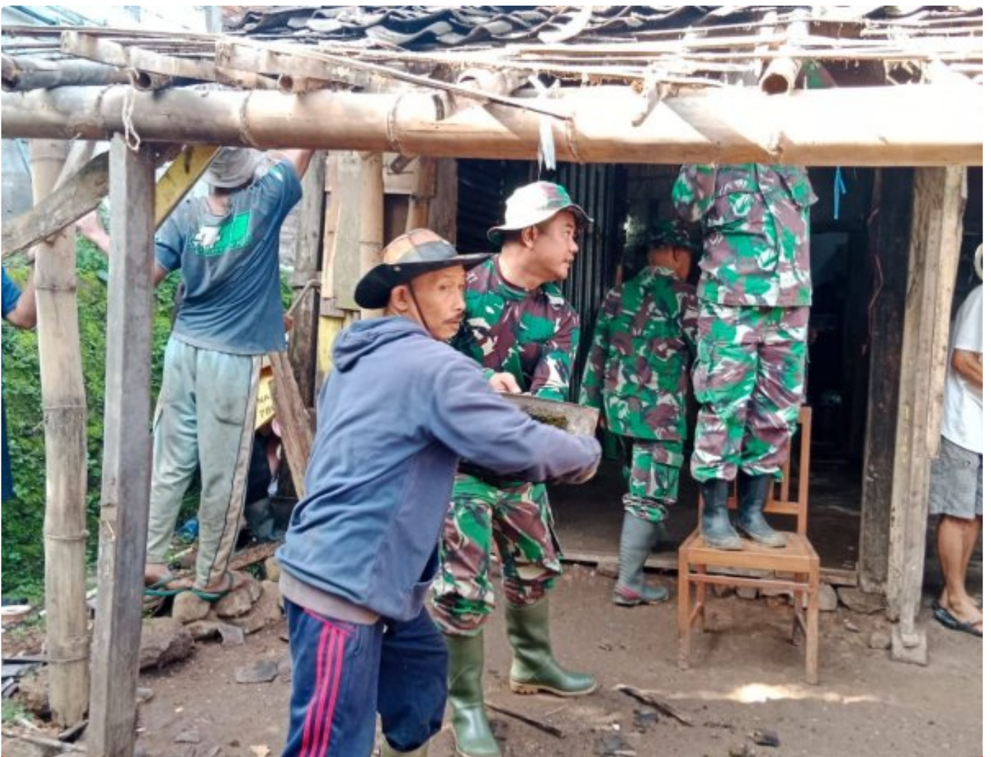
Pembongkar Rumah Sasaran RTLH
