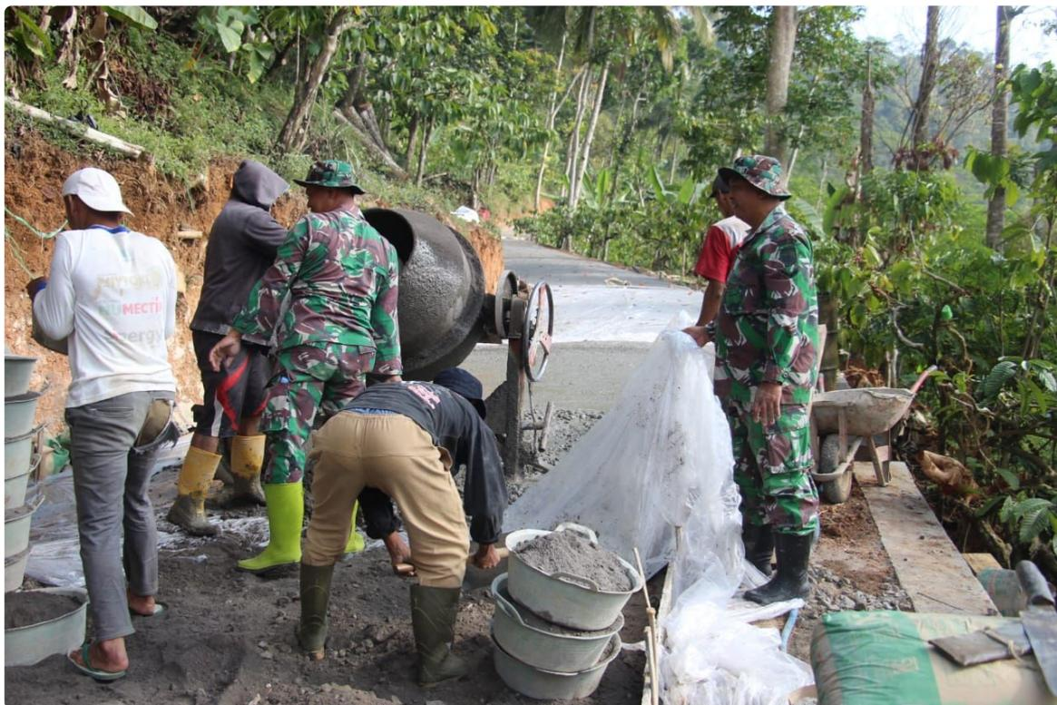
Pekerjaan pengecoran/betonisasi jalan Satgas TMMD Kodim 0706/Temanggung bersama warga tengah menggelar plastik sebagai alas cor beton yang berhubungan dengan tanah, berfungsi untuk menahan agar air semen tidak merembes ke dalam tanah.
